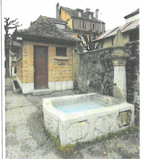
Un bancomat Raiffeisen sera installé dans le bâtiment des toilettes publiques, à Auvernier. RICHARD LEUENBERGER
